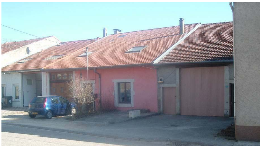
Alignements des égouts de toiture, encadrements lisibles des ouvertures
