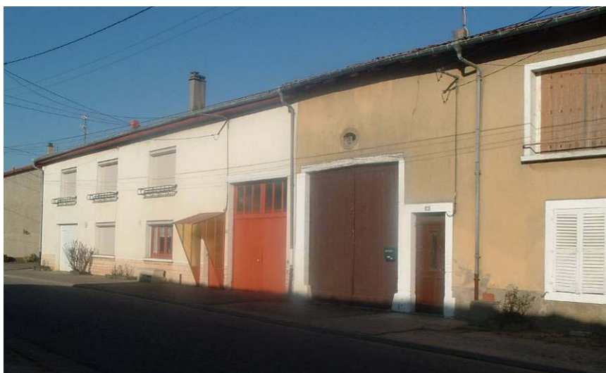
Fenêtres plus hautes que larges contraire à l'architecture traditionnelle lorraine
