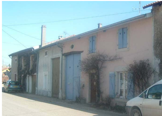
Porte charretière avec linteau en bois, œil de boeuf
